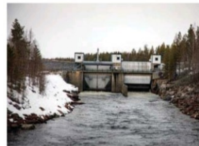
Malgomajs kraftverk i Vilhelmina kommun. Ett av 44 kraftverk i Ångermanälvens avrinningsområde. FOTO: DAVID SANDSTRÖM
