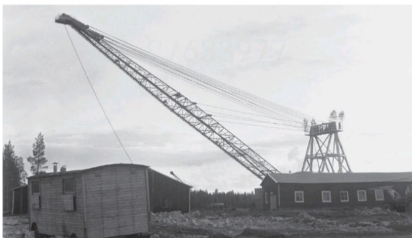
Malgomajbygget i Bullerforsen, Laxbäcken, och den gigantiska grävmaskinen "Marion" på plats för damm- och kanalarbete. Marion kunde gräva 200 kubikmeter i timmen.
