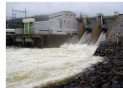
Stenkullafors kraftverk i Åsele. Ett av 44 vattenkraftverk i Ångermanälven med biflöden. FOTO: ARKIV
