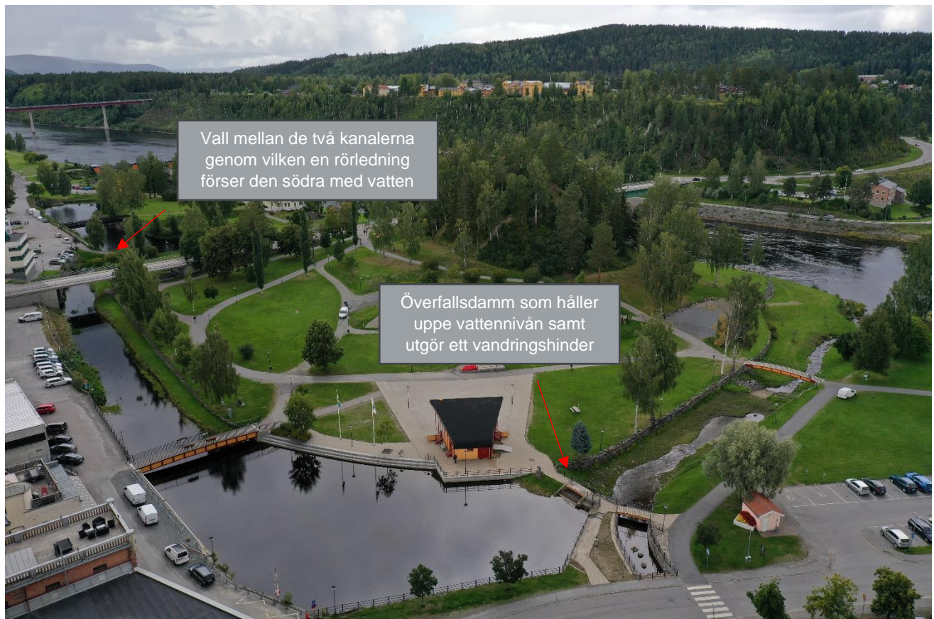
Figur 12. Södra kanalområdet som även det möjligtvis skulle kunna strömsättas. (Norconsult, 2022)
