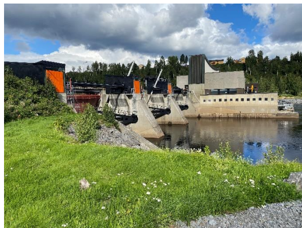
Figur 3. Kraftstationsbyggnad och utskovsparti sett från uppströms och nedströms sidor. Foton 2022-08-31, vattennivå uppströms ca +9,33, vattennivå nedströms ca +0,51. Vattenföring i Ångermanälven vid platsbesöket ca 440 m 3 /s enligt SMHI S-HYPE.
