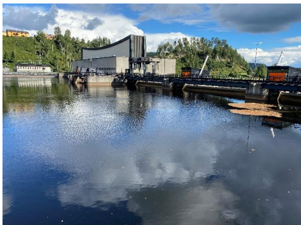
Figur 3. Kraftstationsbyggnad och utskovsparti sett från uppströms och nedströms sidor. Foton 2022-08-31, vattennivå uppströms ca +9,33, vattennivå nedströms ca +0,51. Vattenföring i Ångermanälven vid platsbesöket ca 440 m 3 /s enligt SMHI S-HYPE.
