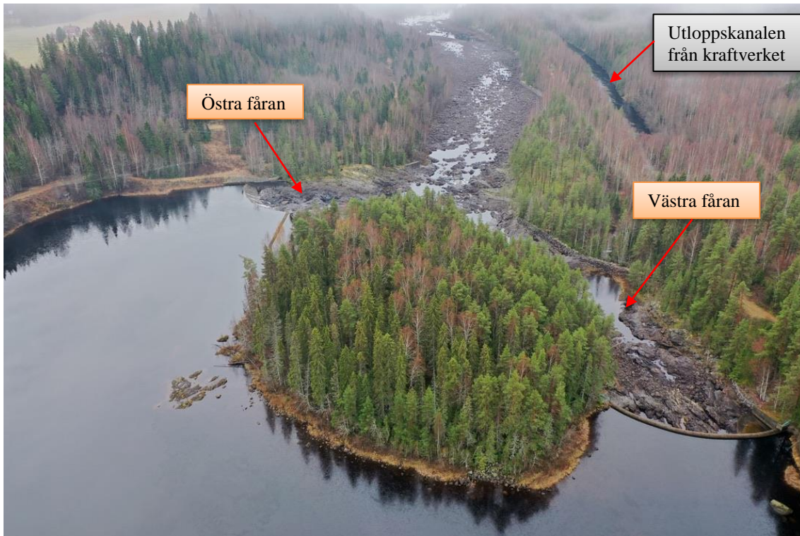
Översiktsbild över Holaforsen, där det tydligt syns att den västra fåran lämpar sig bäst för fiskvandring.
