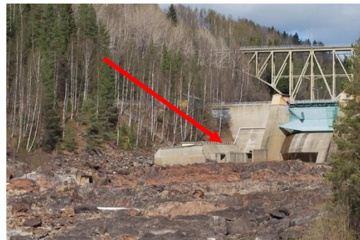
Betongstommen kvar vid fiskhissen.
