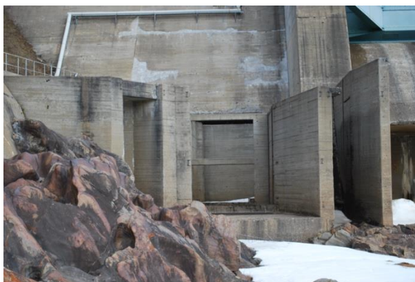
Betongstommen finns kvar vid fiskhissen.
