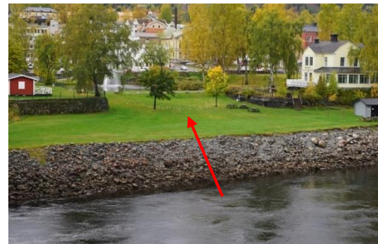
Dammvallen som hindrar kanalens vatten att strömma ned till Ångermanälven, innan regleringen strömmade vattnet genom kanalen
