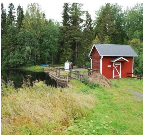
Regleringsdammen vid Tunsjöns utlopp.
