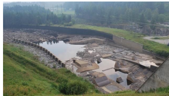
Stora förstärkningar har gjorts vid ytterkurvan, och flera strömdämpare har byggts nedanför dammluckorna.
