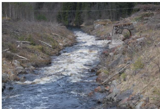
Spillfåran nedanför regleringsdammen.
