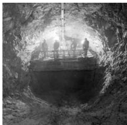
Tunnelbygge från Kultsjön ned till Stalon. Foto: Vilhelmina fotoarkiv.
