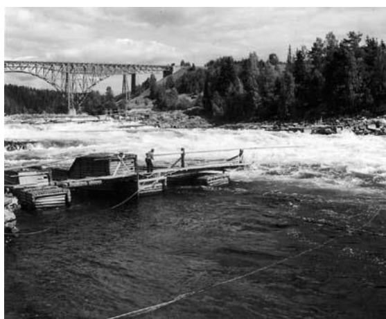
Notfiske nedströms Forsmos järnvägsbro (Foto: Murberget).
