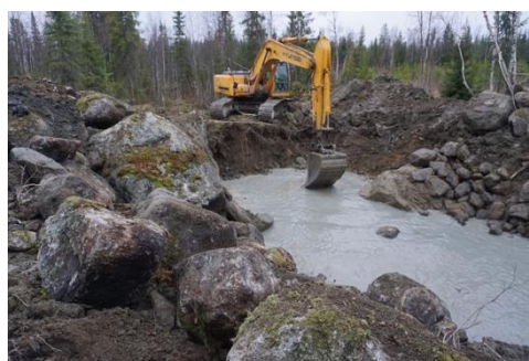
Grävarbete i bifåran (ca 900 m).
