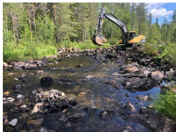
Restaureringen av Mesjöbäcken.
