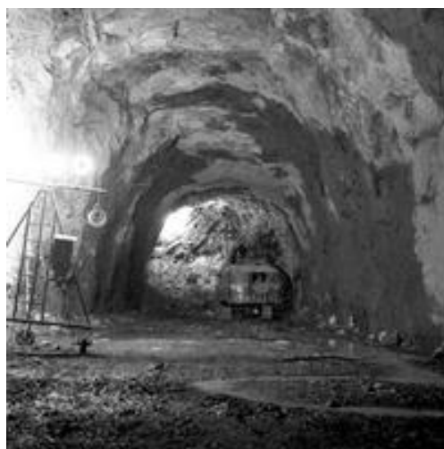
Tunnelbygget. Foto: Vilhelmina fotoarkiv.
