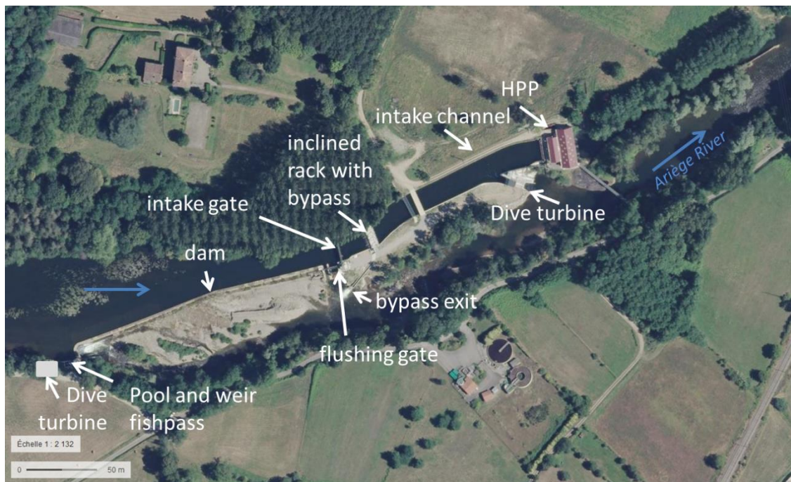
Översiktsbild på de dubbla kraftverken vid Las Rives, Ariège. Källa: IMFT (Agence Francaise Pour la Biodiversite), EDF. Rapport: Kampa-2018 (Review Policy Requirements And Financing Instruments).
