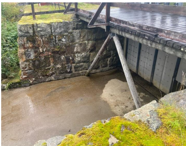
Utskovet på västra sidan av regleringsdammen.
