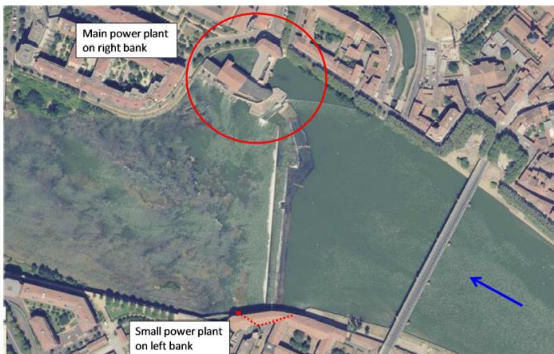
Översiktsbild på de dubbla kraftverken vid Garonne, Toulouse. Källa: IMFT (Agence Francaise Pour la Biodiversite), EDF. Rapport: Kampa-2018 (Review Policy Requirements And Financing Instruments).
