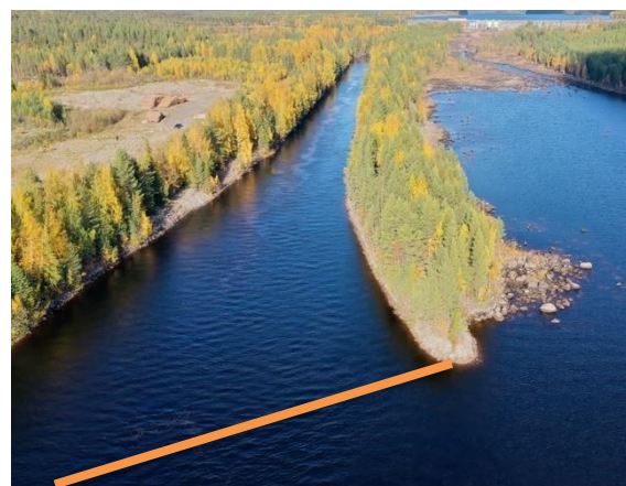
Fiskgaller vid kraftverkskanalens utlopp.
