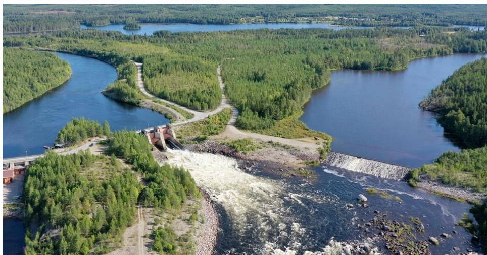
Översiktsbild över området vid Åsele kraftverk.
