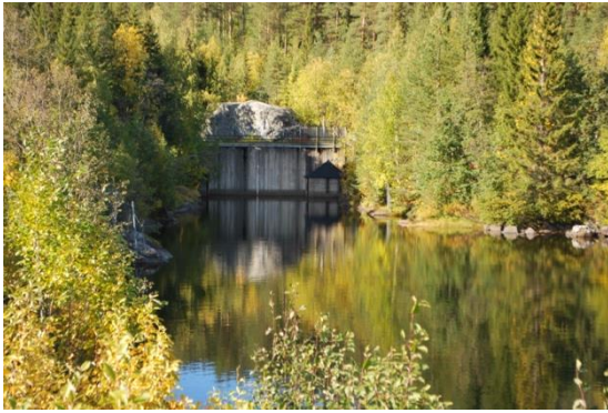
Utloppet från kraftverket.
