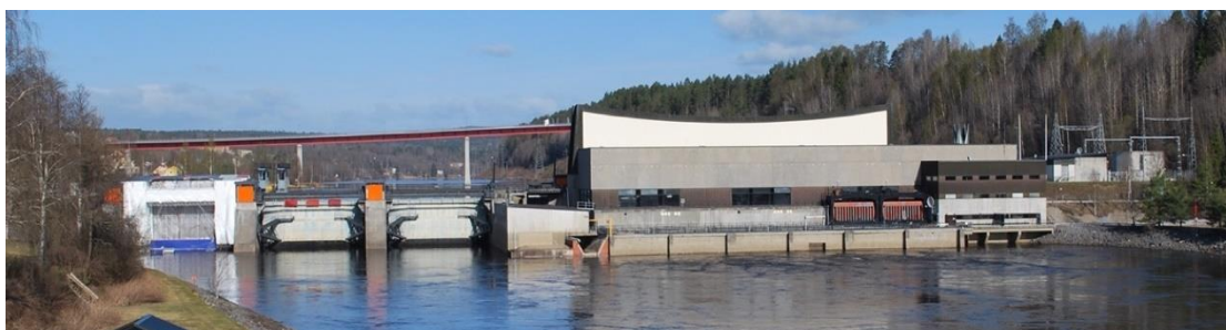
Sollefteå kraftverk. Fotot är taget 2011, en del ombyggnationer har därefter gjorts vid kraftverket.
