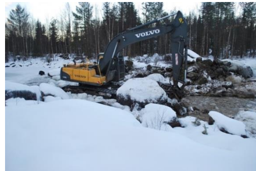
Grävarbetet började julen 2015.
