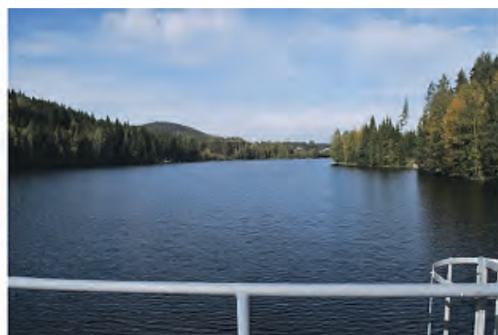
Vattenmagasin uppströms regleringsdammen.
