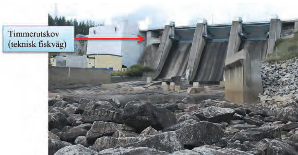
Timmerutskovet vid kraftverket.
