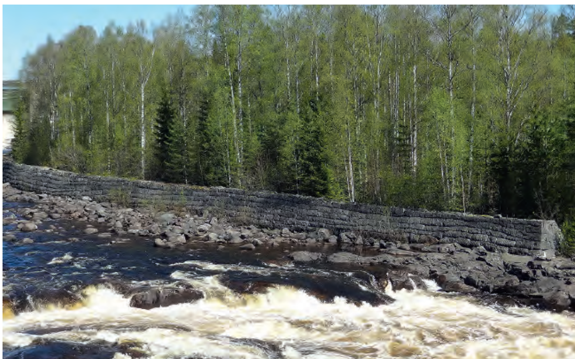
Figur 8. Kilstenmur från flottningsepoken nedströms Lasele kraftverk. Dessa stabila strukturer klarar sig bra mot tidens tand, medan timmerrännorna av trä oftast försvunnit.
