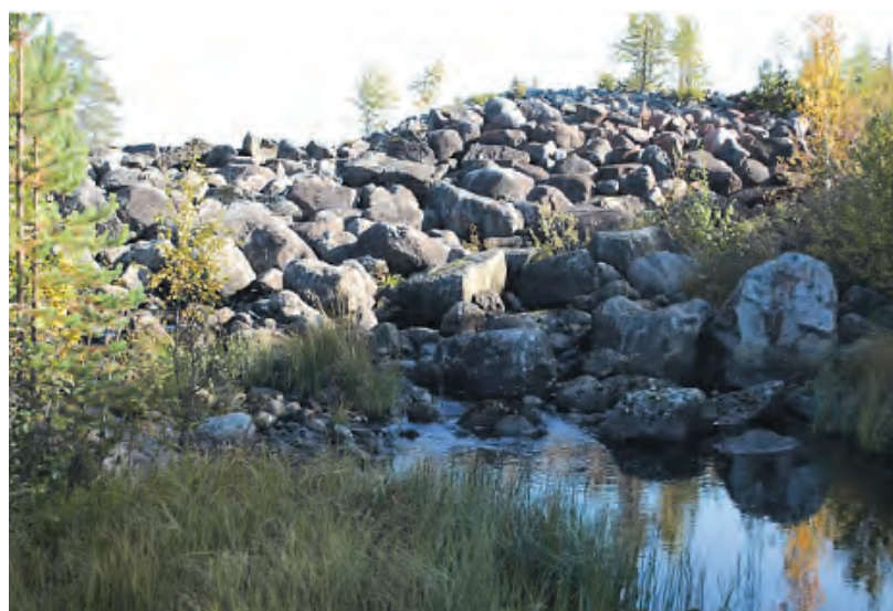
Tröskel vid spegeldammen som är i nära anslutning till regleringsdammen.
