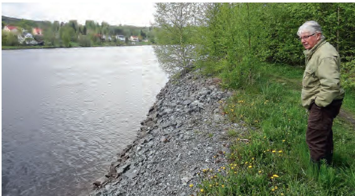
Figur 29. Lennart Norström som var med och skötte tillsyn av erosionsskydden efter byggnationen av Sollefteå kraftverk återvänder för att studera deras status idag. Längre uppströms var de överdämda i slutet av maj 2015.
