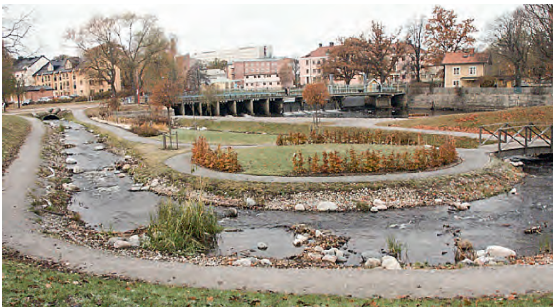
Figur 31. Omlöpet runt Slussen i Örebro (Svartån). Omlöpet har blivit ett viktigt strömhabitat i den lugnflytande ån.
