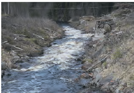
Fotot taget från dammvallen nedströms torr/spillfåran.
