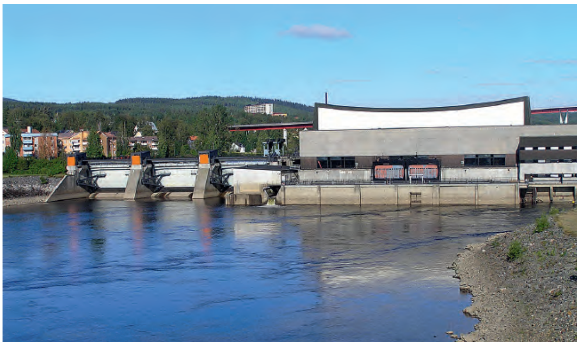
Figur 4. Hit till Sollefteåforsens kraftstation når den vilda laxen under sin vandring från Östersjön, det vill säga den kan vandra de 8 mil hit upp längs Ångermanälven från Höga kusten. Men här är det sedan 1966 stopp för all fiskvandring vidare upp i Ångermanälvens avrinningsystem vars vattendrag har källor långt upp i Jämtland, Västerbotten och norska Trøndelag.
