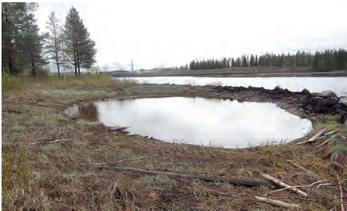
Figur 33. En konstgjord refugedamm som skapats vid ett utflöde av ett litet vattendrag (surdråg) för att behålla vatten under perioder när magasinet är lågt. I större magasin kan refugedammarna göras betydligt större, se vårt förslag för Vojmsjön (Sjölander m.fl. 2009).
