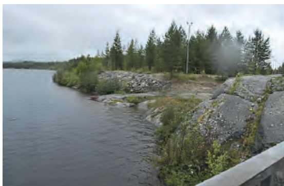
Inloppet på omlöpet (uppströms kraftverk).
