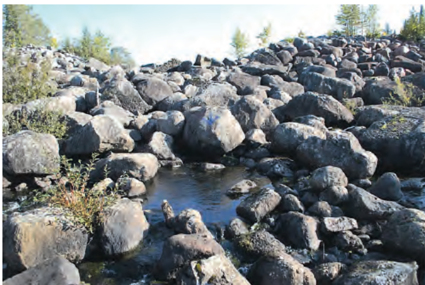
Vid utloppet på spegeldammen rinner bäcken från Skärsjön ut till Ångermanälven, men det torde vara omöjligt för vandrande fiskar att ta sig genom detta stenröse vid tröskeln eftersom bäcken rinner igenom och inte ovanpå de stora blocken och stenarna.
