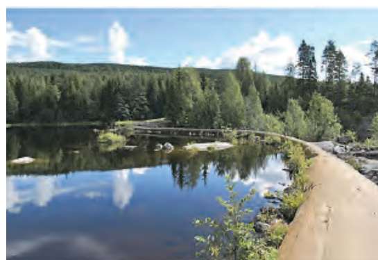
Betongtröskeln vid Hällforsen.
