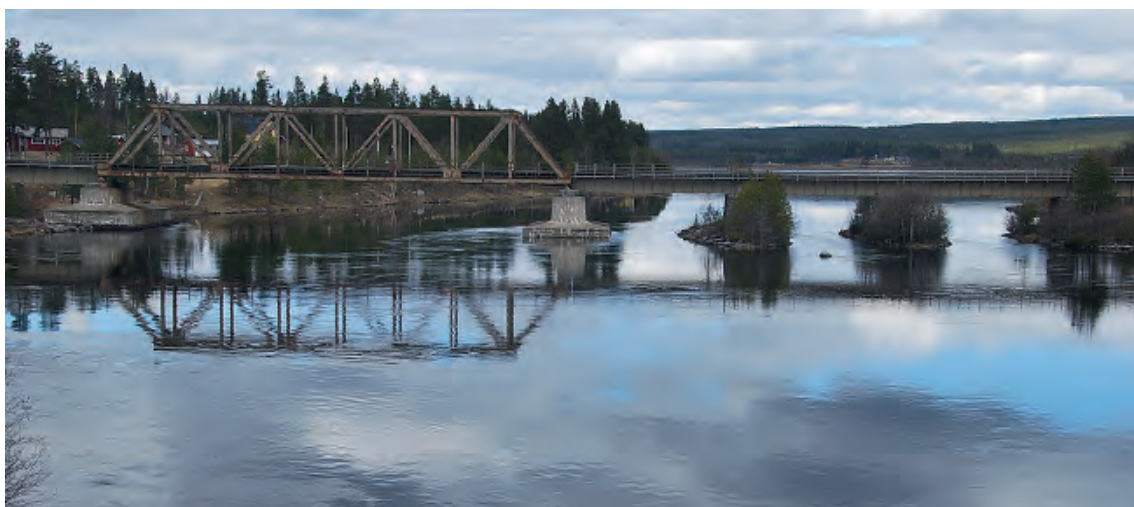
Figur 24. Meselefors. Bilden tagen från landsvägsbron (E45:an) och uppströms mot järnvägsbron. Förr hade bron både tåg- och biltrafik så det gällde att kolla att bron var fri om man ville köra över med bil.
