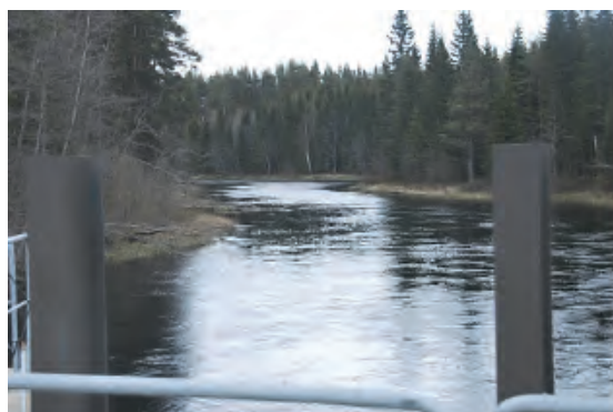
Dammvallen med intaget av vatten till kraftverket och dammluckor.
