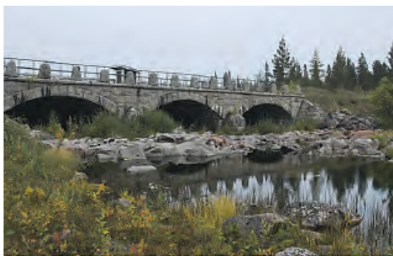
Valvbron (järnvägsbron) av granit över Lillån.
