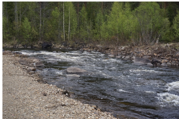
Utloppet till Ångermanälven efter åtgärd
