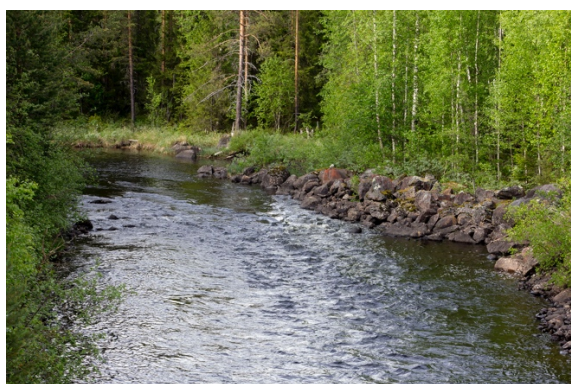
Strax ovanför landsvägsbron (väg 90) innan åtgärd.
