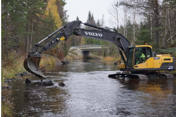
Strax nedanför landsvägsbron började arbetet 2016.
