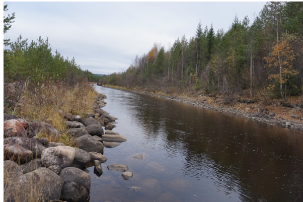
Dammvallen och kanalen innan åtgärd.
