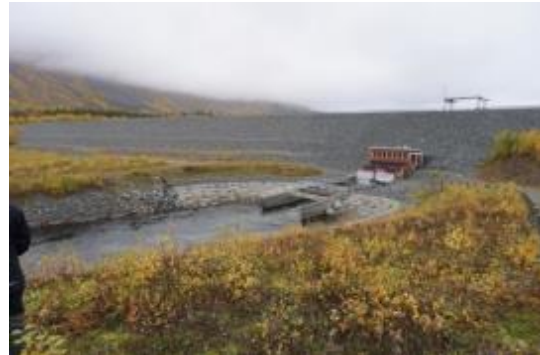
Utskoret från regleringsdammen.
