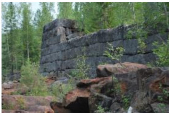
Stenkista vid landsvägsbron.
