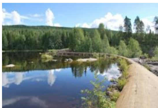
Betongtröskeln vid Hällforsen.
