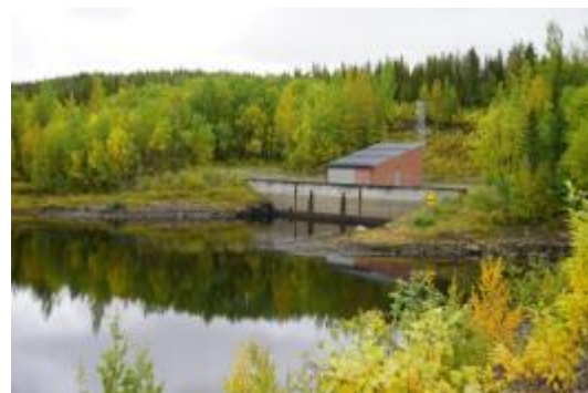
Åsjön, intag för tunnel ned till Matsselet.
