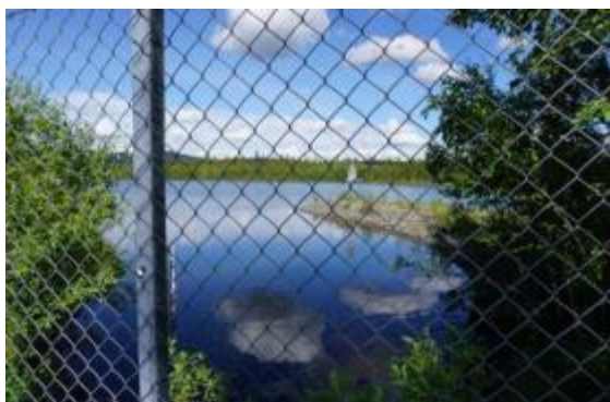
Intaget till tunneln.
