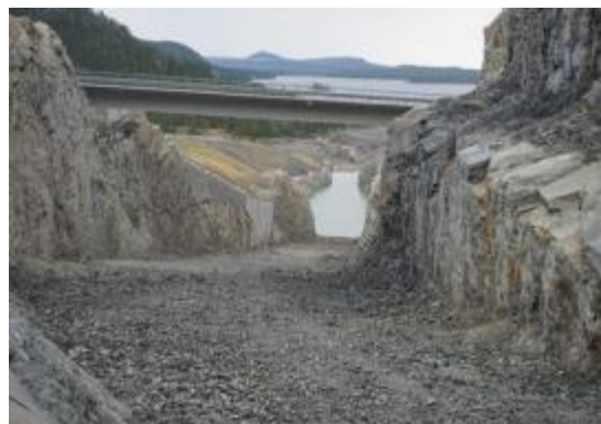
Nödtappningskanalen.
