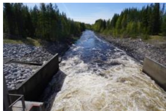
Utloppskanalen från Ormsjödammen.
