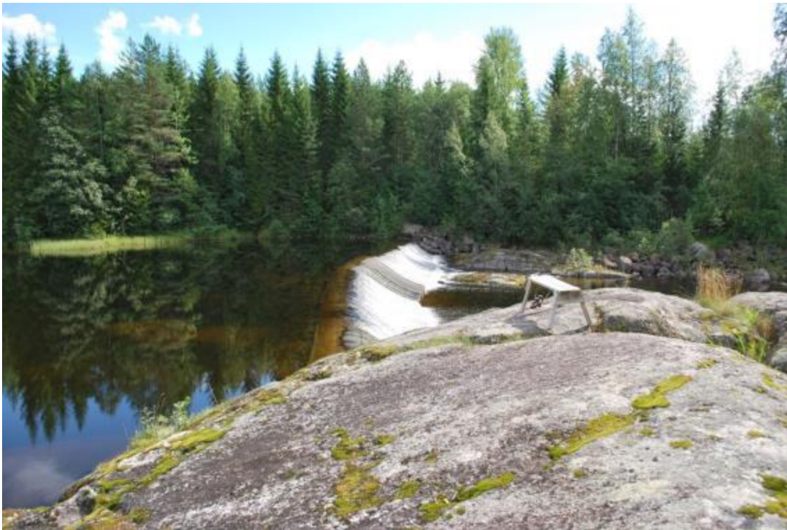
Tröskel vid Hällforsen som utgör vandringshinder och skapar onaturliga sel.
