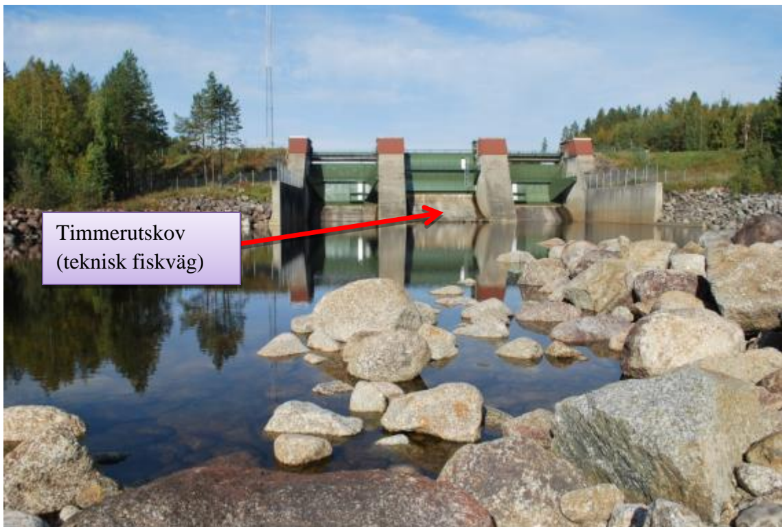
En teknisk fiskväg ska vara möjlig att anlägga vid det gamla utskovet.
