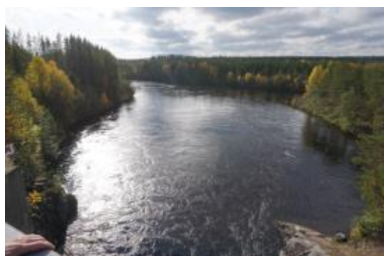
Utloppet från kraftverket.
