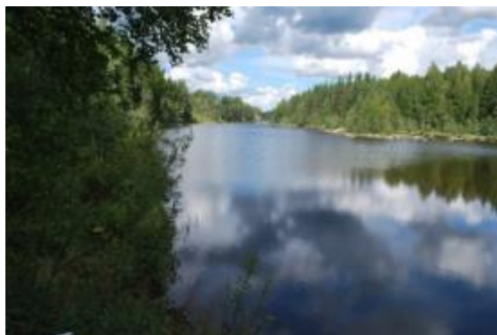
Spegeldammen uppströms tröskeln.
