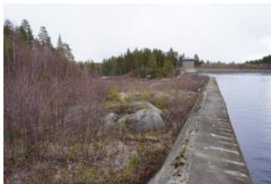
Vid den norra sidan av betongdammen är höjdskillnaden liten mellan vattenytan och marken nedanför dammen.
