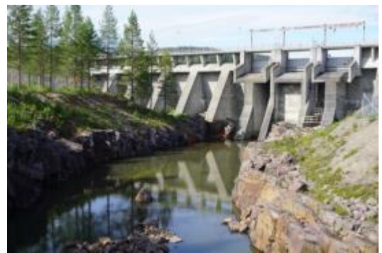
Utskovet vid regleringsdammen.
