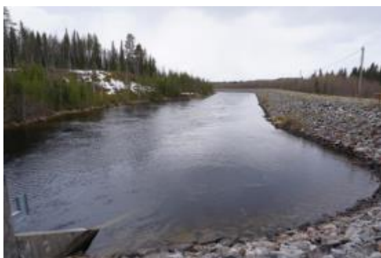
Inloppskanalen till kraftverket.
