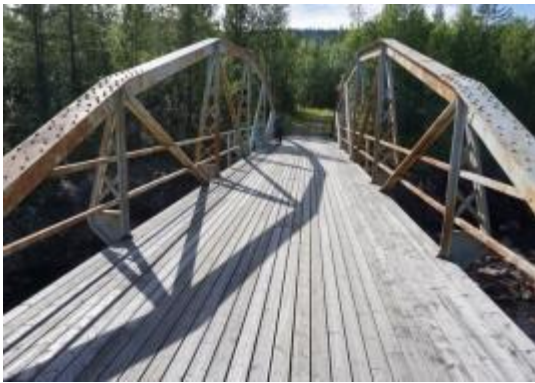
Bro nedanför regleringsdammen.
