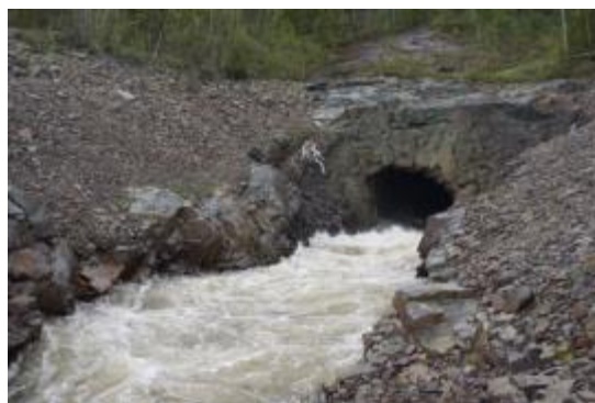
Utloppet från tunneln in i Dabbsjön.
