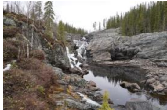
Korpån efter överledningen till Dabbsjön. Trots att fotot togs under vårfloden strömmar nästan inget vatten.
