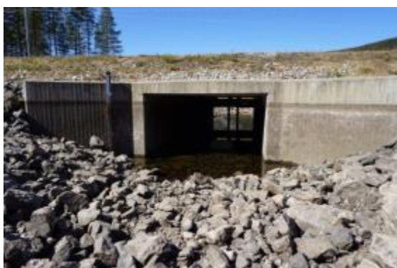
Omlöp vid regleringsdammen (torrlagd).
