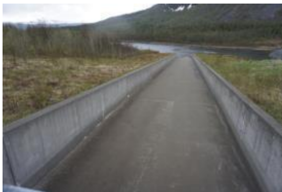
Nedre delen av nödtappningskanalen.
