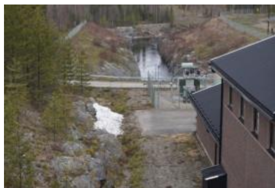
Utloppskanalen från kraftverket.
