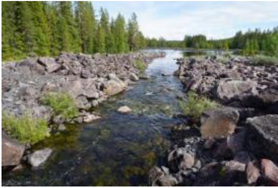
Grävda kanalen nedanför Hansselet.
