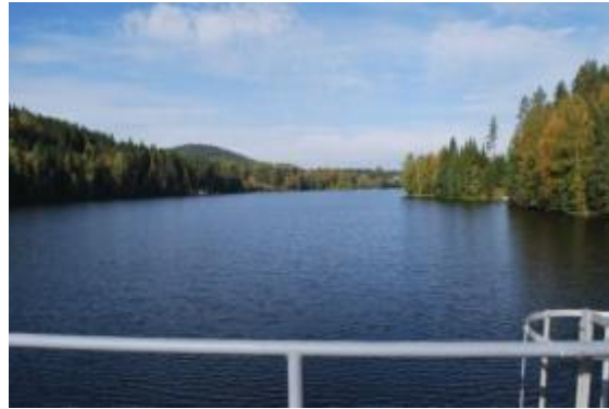
Vattenmagasin uppströms regleringsdammen.
