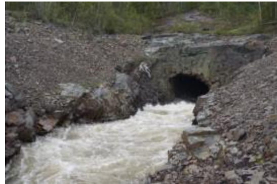
Korpån överleds via en tunnel in i Dabbsjön.
