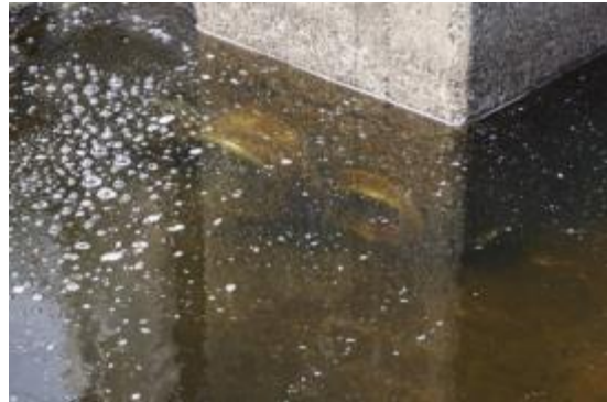
Tappningen till Korpån går via två rör.
