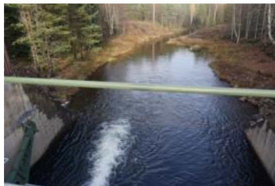
Grävd kanal från Faxälven till Vängelälven.
