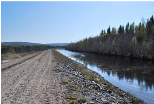
Kanalen från Ledingsjön till Ledinge kraftverk.
