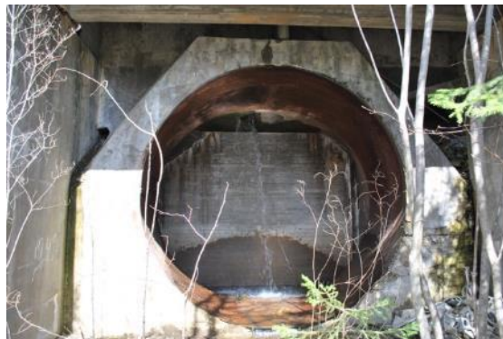
Där skovelhjulet en gång satt, i gamla kraftverket.
