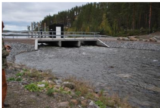
Betongkonstruktionen vid utloppet från Sporr sjön.
