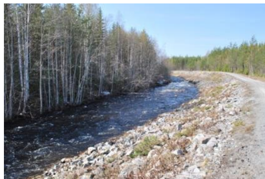
Kanalen från Finnån ned till Ledinge Kraftverk.
