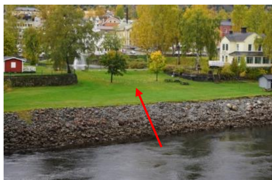
Dammvallen som hindrar kanalens vatten att strömma ned till Ångermanälven, innan regleringen strömmade vattnet genom kanalen.
