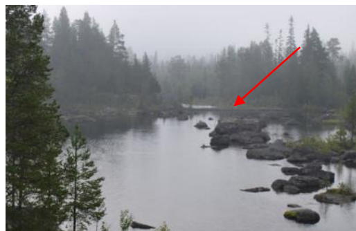
Betongdammen som hindrar vattnet från höljan att strömma in i Lillån.
