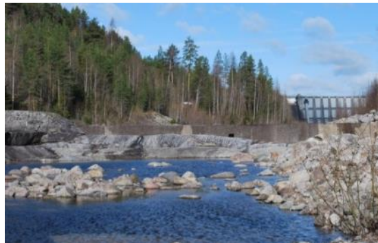
Tröskel/grunddamm strax ovanför landsvägsbron.
