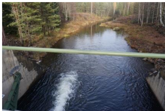
Grävd kanal från Faxälven till Vängelälven.
