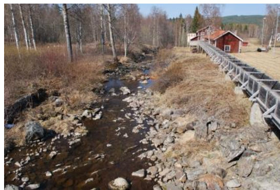
Bruksån och vattenrännan som leder till bruket.
