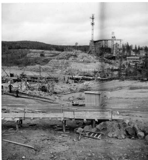
Byggnationen av Storfinnforsens kraftverk. Bild: Murberget.
