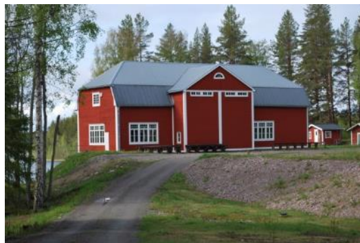
Gamla Lövön kraftstation.
