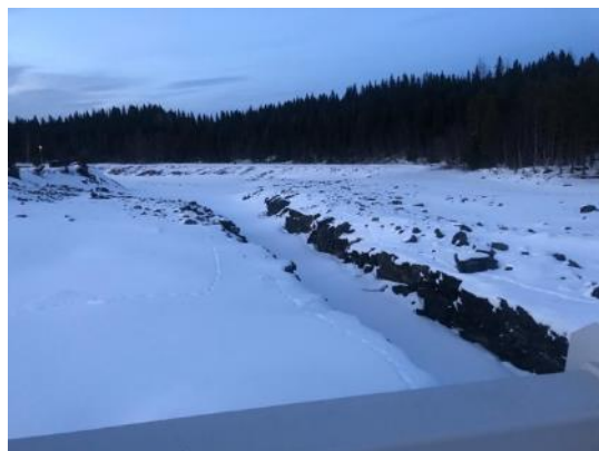
Kanalen som leder in till dammen.
