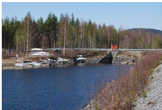
Intaget till kraftverket.
