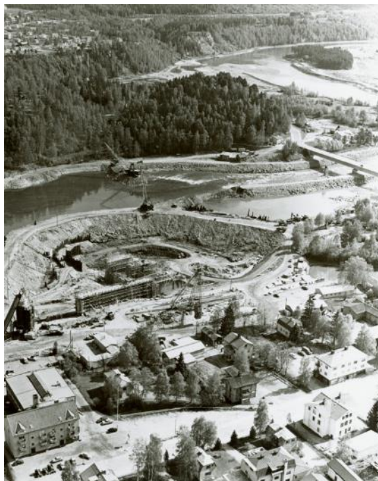
Bild från byggandet av Sollefteå kraftverk och regleringsdamm. (Foto: Murberget).
