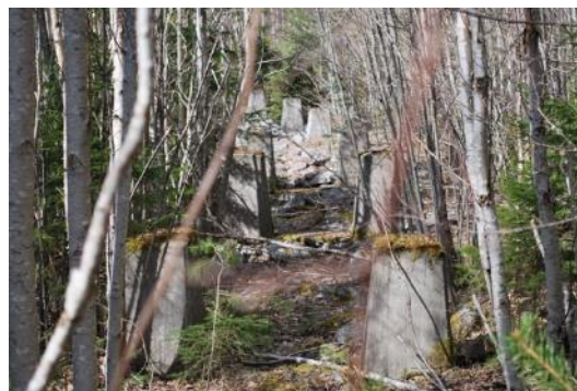
Betongfundamenten till timmerrännan.
