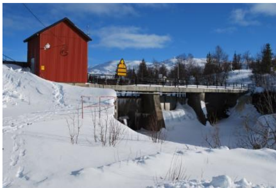
Regleringsdammen som ligger strax bredvid Kraftverket.
