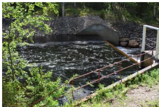
Dammen/tröskeln och intaget till tunnel.
