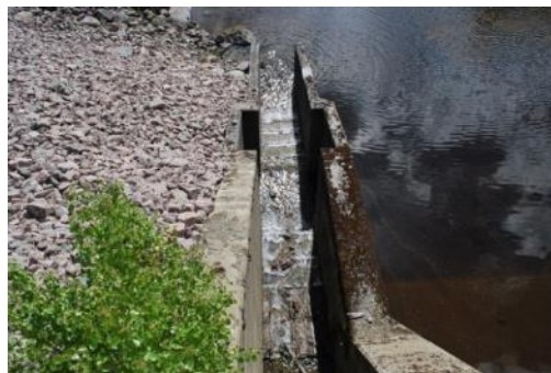
Gamla fiskvägen vid regleringsdammen, inte
