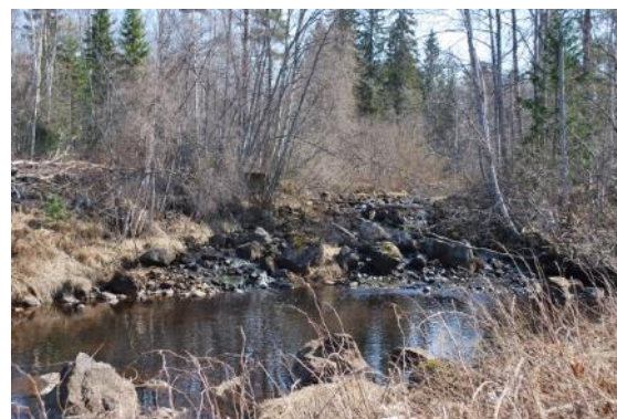
Bruksån just innan kanalen från kraftverket strömmar in i ån. När bilden togs var ån i stort sett torrlagd. Trots att det var vårflood.
