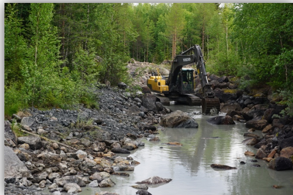
Bild 18: Fördjupning och iustering av fåran
