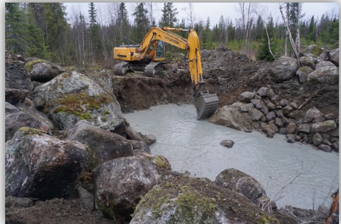
Bild 9: Grävmaskin i arbete
