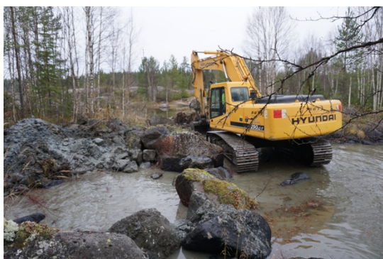
Bild 6: Grävmaskin i arbete vid inloppet
