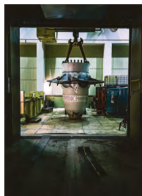
Turbinens löphjul har lyfts upp på maskinsalens golv för att monteras isär. Delarna ska transporteras till Jämtland för reparation.
