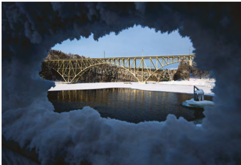
Ovanför kraftverket sträcker sig den vackra Forsmo järnvägsbro över Ångermanälven. Utöver Forsmo längst söderut har Vattenfall sju stora kraftverk i älven.
