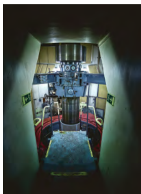
Det krävs stabila konstruktioner för att klara påfrestningarna vid ett vattenkraftverk. Här syns en av de snurrande turbinaxlarna.
